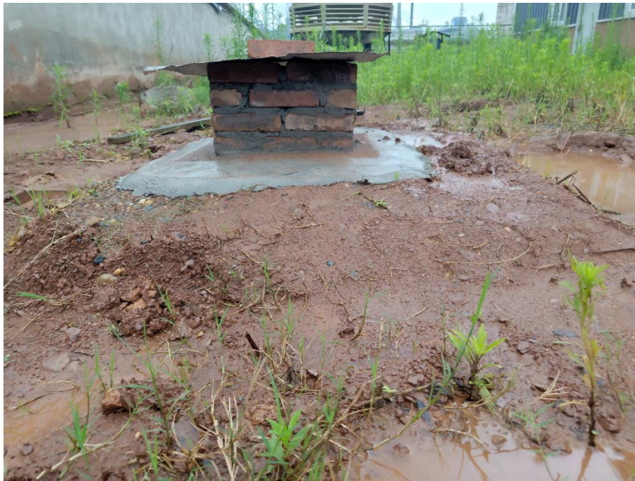
地下水监测井
