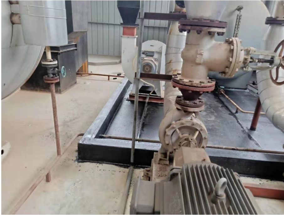
储油罐围堰
